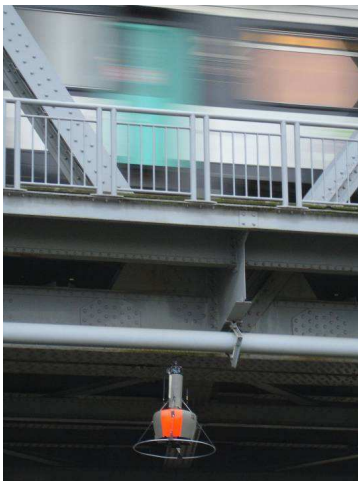
Viaduc de l'Eauplet.
